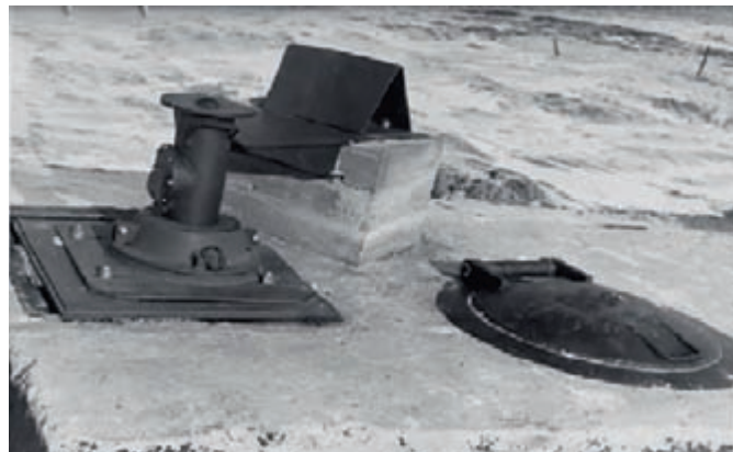
Антенное устройство средства отвращения ПРП «Отвод» (ЗРК С-200)
